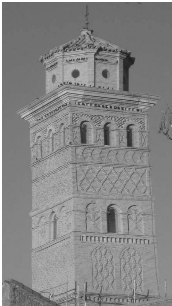
Figura 19. (2013. foto de los autores) Estado exterior final de las restauraciones
