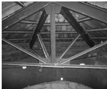
Figura 06. (2006. foto de los autores) Estructura de cubierta sobre el ábside
