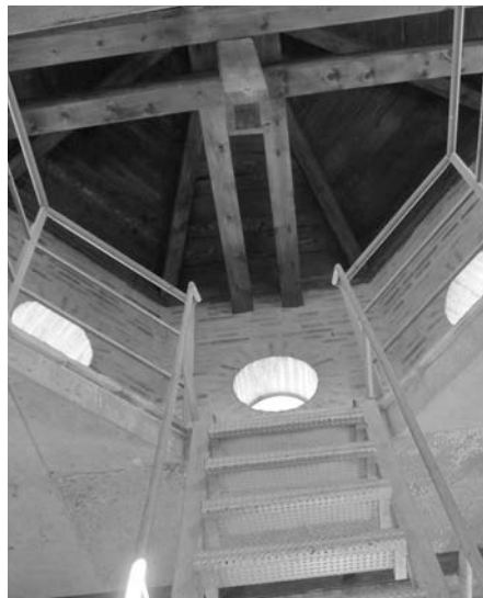
Figura 13. (2011. foto de los autores) Estado final restauración cuerpo octogonal
