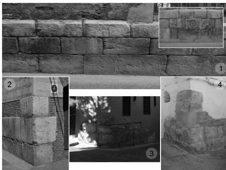
8. 1) Zócalo de Colegio de la Compañía de Jesús (Sede actual UNED) fachada calle José Llanas. 2) Palacio de la plaza Erlueta, núm. 1. 3) Palacio calle San Miguel, núm. 13. 4) Reutilización de sillares romanos en edificaciones de Huérmeda (calle Real, 2). (Imágs: autor).
