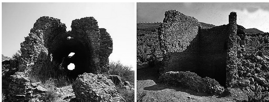
6. Cisternas ubicadas en las laderas de San Paterno confundidas por Labaña con termas. Se aprecia su construcción mediante encofrados de opus caementicium (Imágenes: autor).
