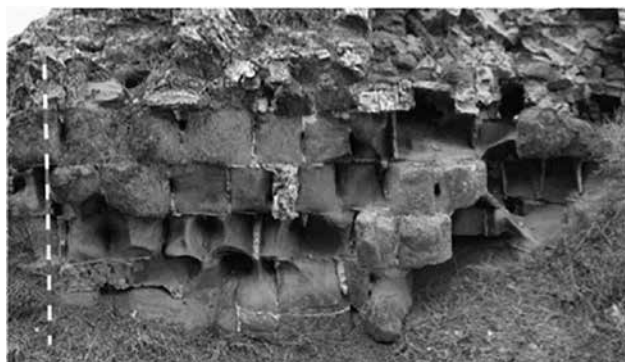
Foto 2. Muro de sillares dispuestos a tizón en la pared norte del recinto superior del castillo de Tamarite de Litera. Fotografía propia.
