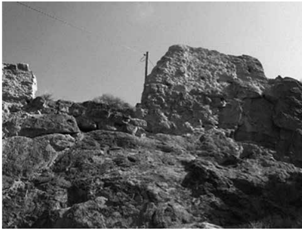
Foto 3. Muro de tapial sobre zócalo de sillares en el recinto de la zona al este del hisn de Tamarite de Litera. Fotografía propia.
