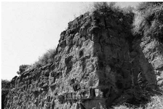
Foto 1. Muro de sillares a soga y tizón, con cubo en saliente, en la zona este del castillo de Tamarite de Litera. Fotografía propia.
